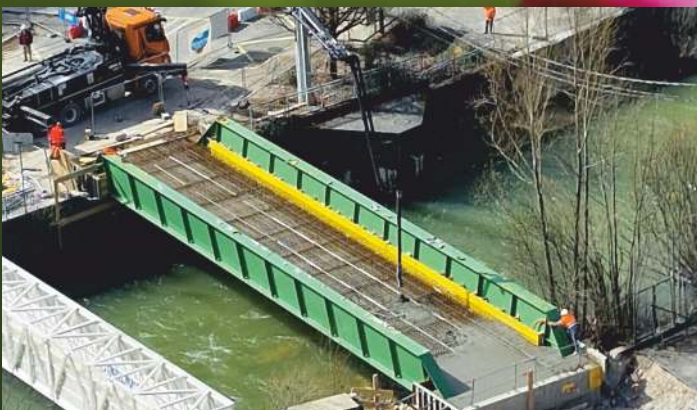
Les travaux se poursuivent sur le Pont de la Pipe avec le coulage du béton en mars.
