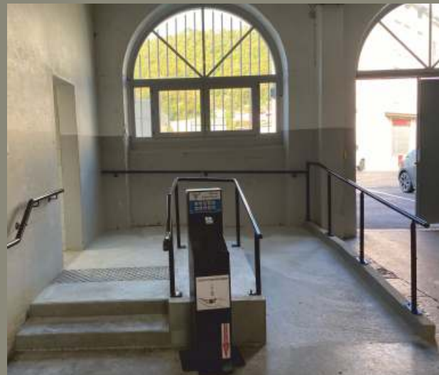
Rampe d'accès aux toilettes pour personnes à mobilité réduite, installée à l'intérieur de la Grenette.
