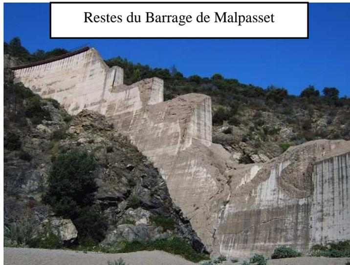
La rupture dépend des caractéristiques propres du barrage, elle peut être **lente**, dans le cas barrage poids, par érosion ou par infiltration d'eau dans le remblais ou **rapide** en cas de rupture d'un barrage voûte, lequel casse en libérant toute la retenue en une seule fois ou dans le cas d'un renversement de barrage poids, si son poids devient insuffisant pour retenir l'eau.
