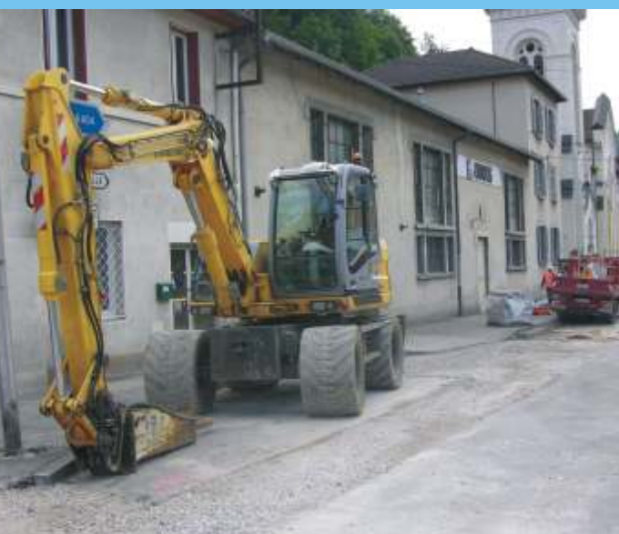
Travaux de réfection des chaussées de la rue du Collège et de la rue Voltaire, du 15 au 24 juin.
