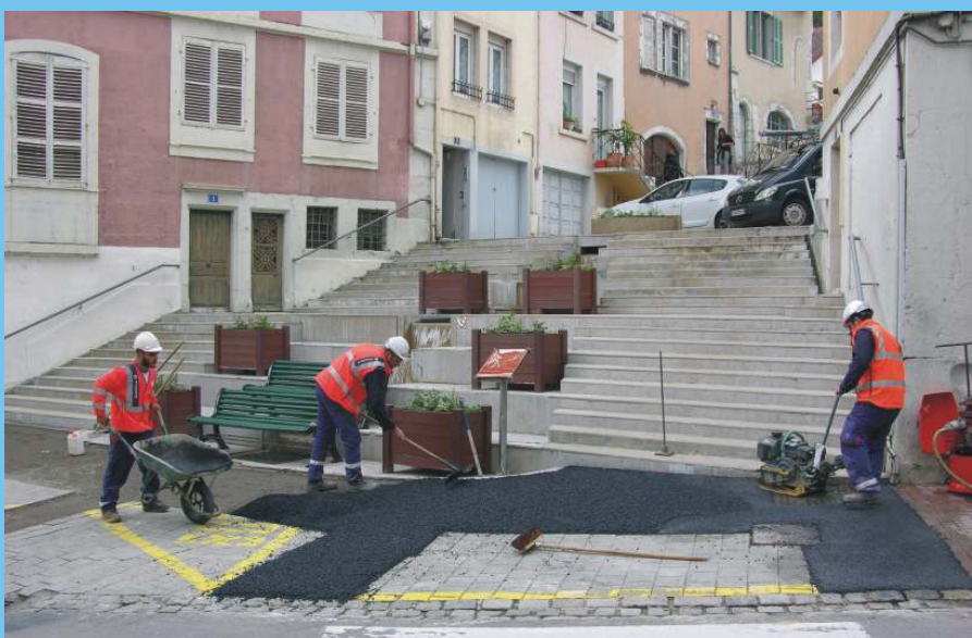
Travaux menés sur les pavés de la montée Saint-Romain, le mercredi 20 mai.
